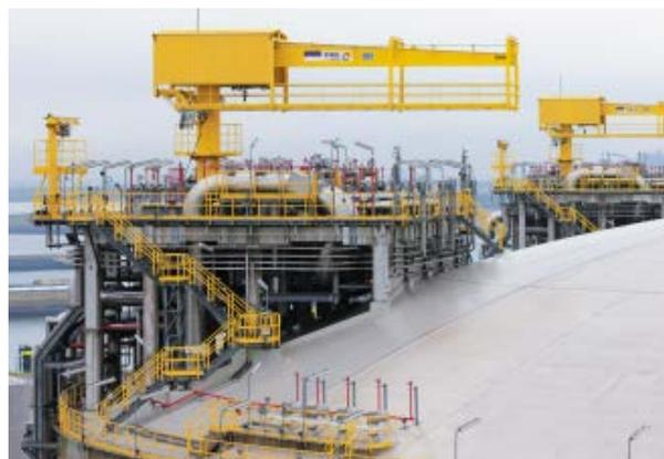
4 Para los trabajos de mantenimiento en las bombas de los tanques de gas licuado se emplean equipos de elevación LNG especiales. Los polipastos de cable están equipados con dos tambores de cable con accionamiento separado y una capacidad de carga de 2.400 kg, respectivamente. Una grúa giratoria pequeña adicional está equipada con un polipasto de cable SH 30 ex y se emplea como grúa auxiliar para transportar herramientas y elementos de obra hasta la plataforma del tanque.
