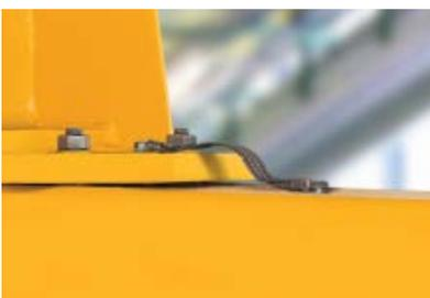
Durante la instalación de la tecnología de grúa en zonas potencialmente explosivas es obligatoria una equalización de potencial para evitar chispas que puedan producir ignición.
